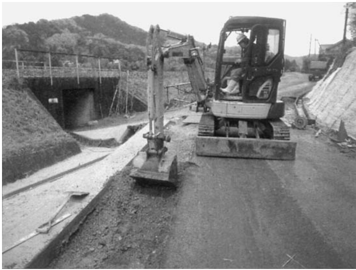
経済対策による維持工事現場
